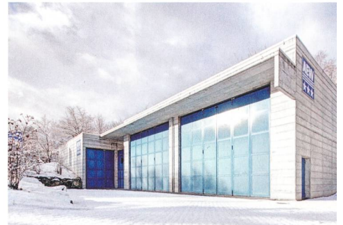
Aussenansicht eines AEW-Unterwerks.
