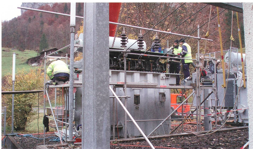
Revision eines Transformators.
