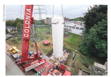
**Bild 5** Aufstellung des Stickstofftanks in der Station Herkules.
