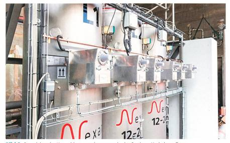
Bild 3 Supraleitender Kurzschlussstrombegrenzer in der Station «Herkules», Essen.
