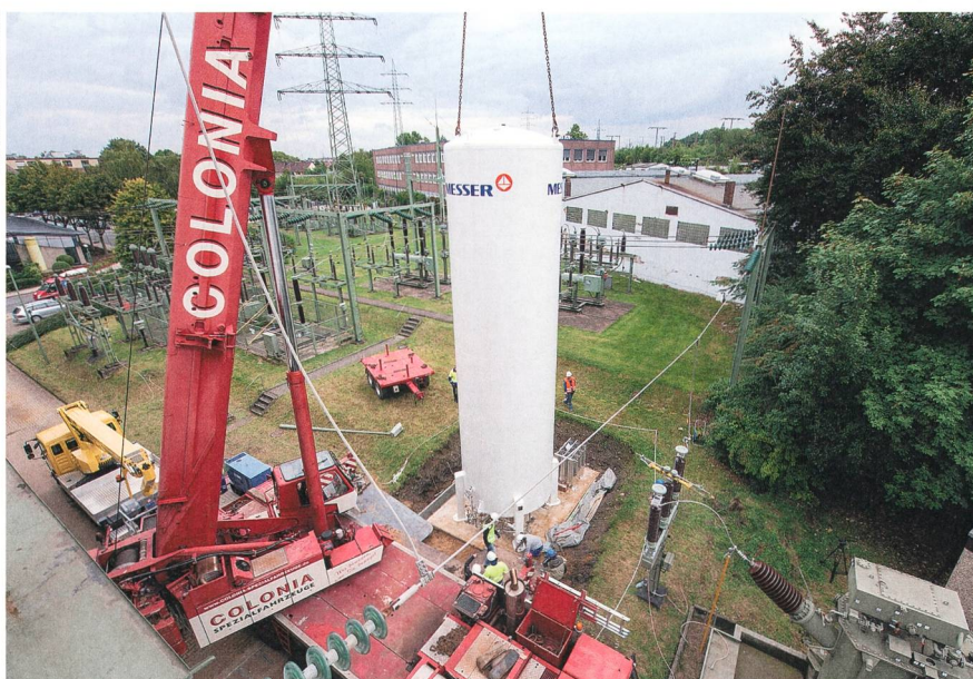
Bild 5 Aufstellung des Stickstofftanks in der Station Herkules.
