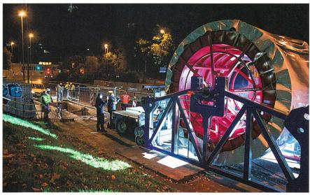
Bild 4 Einzug der ersten HTS-Kabelteillänge.
