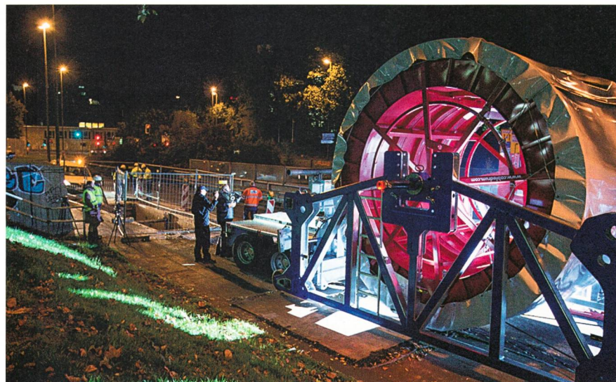
Bild 4 Einzug der ersten HTS-Kabelteillänge.
