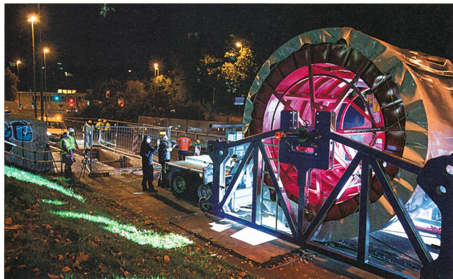
Bild 4 Einzug der ersten HTS-Kabelteillänge.
