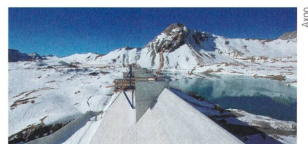
Die Staumauer auf der Muttenalp.
