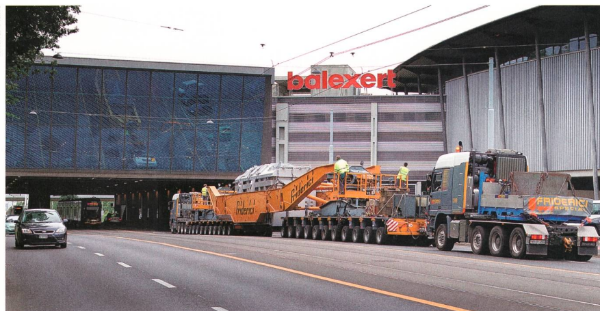
Figure 2 Transport du nouveau transformateur vers le site de Verbois.
