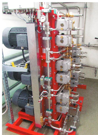
Motoreinheit, die den Hochdruck von 140 bar für den Wasserebel erzeugt.
