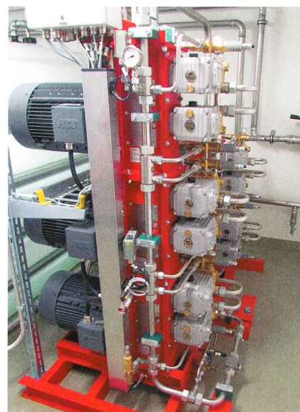
Motoreinheit, die den Hochdruck von 140 bar für den Wassernebel erzeugt.
