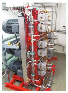
Motoreneinheit, die den Hochdruck von 140 bar für den Wassernebel erzeugt.
