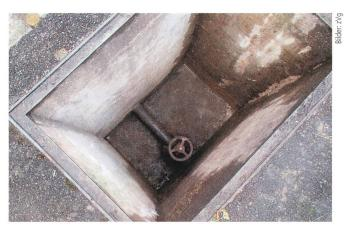
Schacht mit Entleerungsschieber der Druckleitung.
