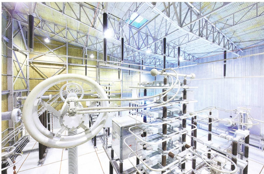
Eine HGÜ-Umrichterstation von ABB.
