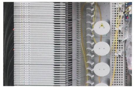
1296 Faserabschlüsse und integriertes Patchkabelmanagement.
