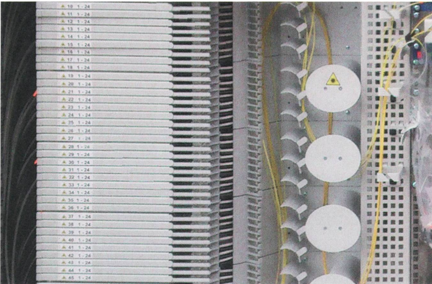
1296 Faserabschlüsse und integriertes Patchkabelmanagement.
