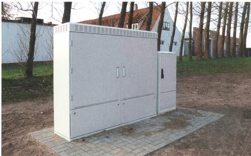
CCM-Aussengehäuse MFG 18 mit externer Zähleranschlusssäule.
