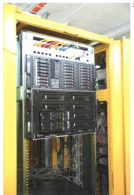
Bild 3 Blick ins Rechenzentrum. Dank der tieferen Temperatur in der Höhenlage benötigen die Server weniger Kühlung.
