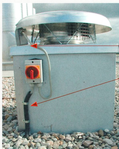
Photo 2 Matériel électrique raccordé à demeure (par ex. ventilateur de toit).
