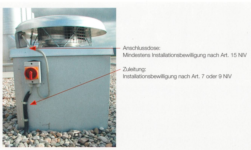
Foto 2 Fest angeschlossenes Erzeugnis (z.B. Dachventilator).
