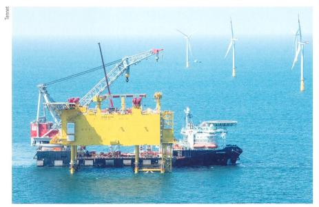
Auf einer Barge wurde die 15 000 t schwere SylWin1-Plattform über die Unterkonstruktion geschleppt. Sie wurde dann abgesenkt und mit der Unterkonstruktion verbunden. Anschliessend hievte sich die Plattform hydraulisch auf ihre Endposition 23 m über dem Meeresspiegel.
