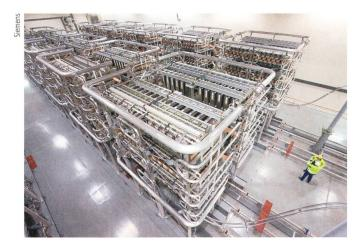
Die Konverter-Halle ist das Herzstück der SylWin-Plattform. Hier wird der in den Windparks generierte Wechselstrom in Gleichstrom umgewandelt, der dann per Seekabel an Land transportiert wird. Die gesamten Übertragungsverluste liegen unter 4%.
