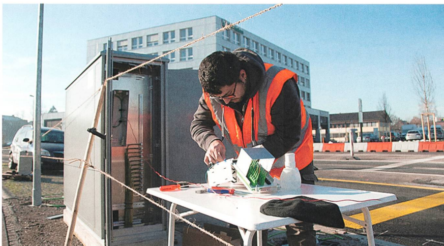
Einführung und Vorbereitung der LWL-Kabel im Verteilkasten.
