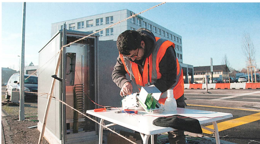
Einführung und Vorbereitung der LWL-Kabel im Verteilkasten.
