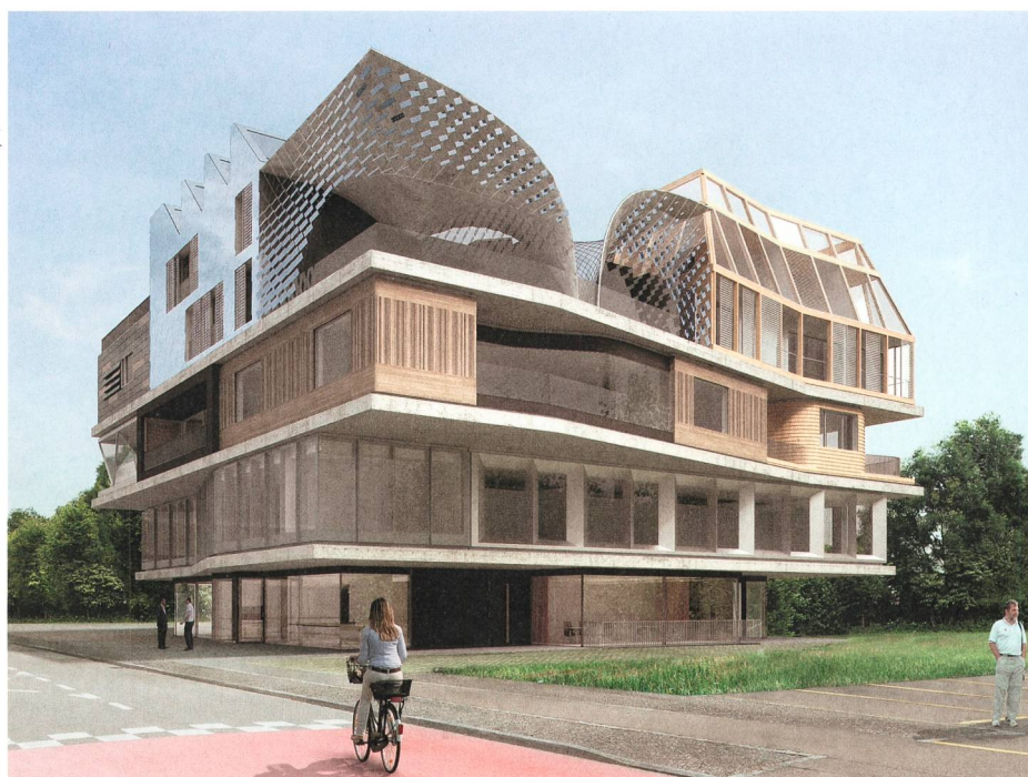
Bild 1 Rendering des Nest-Gebäudes mit adaptiver Fassade an der Empa.
