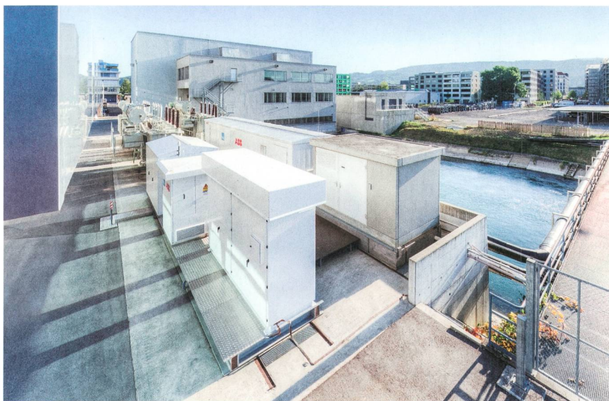
Die Speicherbatterie kann bis zu 500 kWh Energie ins Verteilnetz einspeisen bzw. von dort beziehen.
