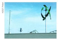
Vertikale Windräder und Windmesser auf einem Dach der Hochschule.
