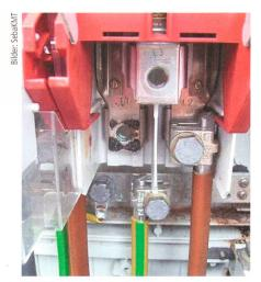
Bild 6 Mangelhafte Verschraubung.
