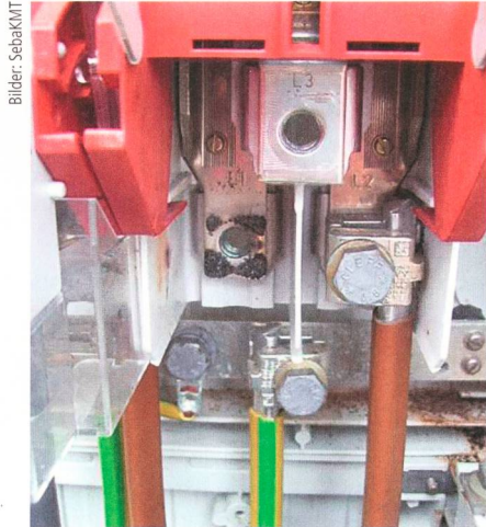
Bild 6 Mangelhafte Verschraubung.
