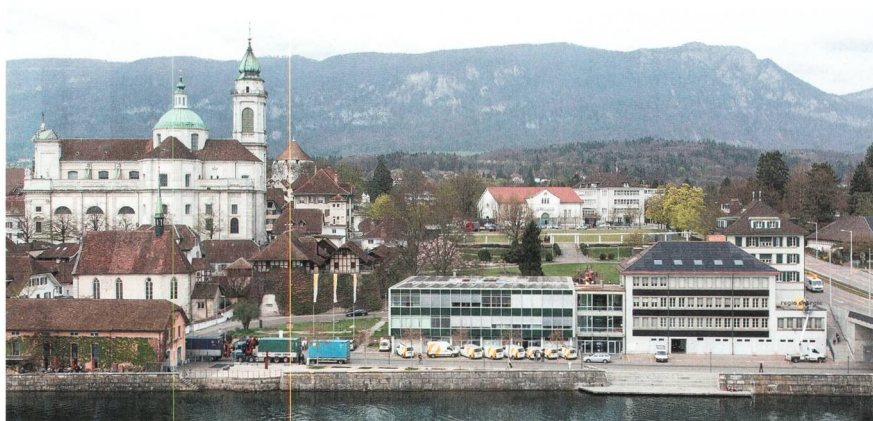
Regio Energie Solothurn hat die Vision, ihr Gebiet in Zukunft energieautark zu versorgen. Mit der neuen Fotovoltaik-Anlage auf dem Hauptgebäude setzt sie ein Zeichen. Ebenso wichtig ist das neue Leitsystem, das für ein Smart Grid und das Energiemanagement vorbereitet ist.
