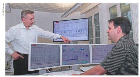
Die Bildschirme zeigen eine grafische Übersicht über das Netz. Die Farbe der Leitung zeigt beispielsweise, von welchem Unterwerk der Strom eingespiesen wird. Links im Bild Patrick Bader, bei Regio Energie Solothurn verantwortlich für das Leitsystem.
