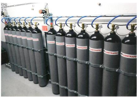
Stickstoffflaschenbatterie für zwei Löschbereiche mit mechanischer Blockiervorrichtung.
