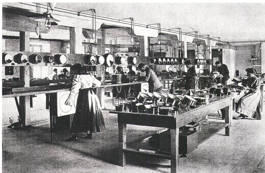
Bild 1 Trüb, Fierz & Co. Hombrechtikon, um 1908: Eichsaal für Gleichstrominstrumente.
