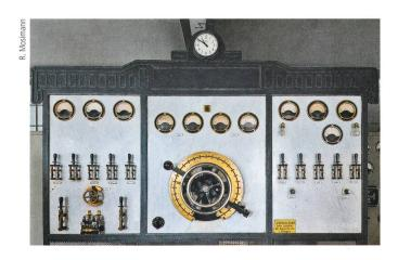
**Bild 2** Alte Schalttafel im historischen Kleinkraftwerk Ottenbach (um 1910).
