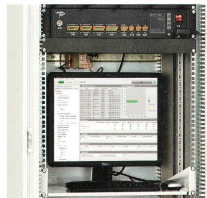
Ein Kommandogerät mit FPS Semagyr-TOP Funktionalität von Landis+Gyr.
