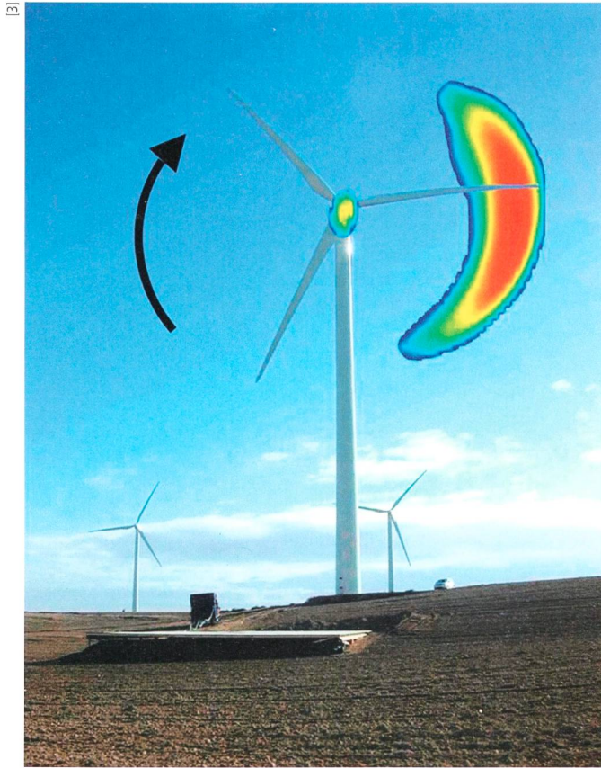
Figure 2 Origine du son perçu par un observateur placé en face de l'éolienne.
