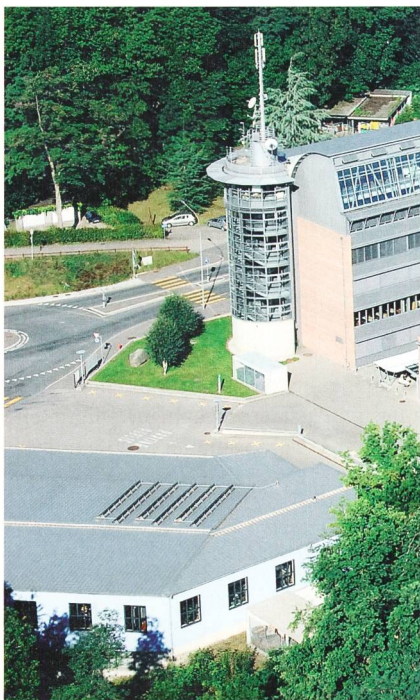
Bild 5 Solaranlage der Hochschule für Technik und Architektur, Freiburg.
