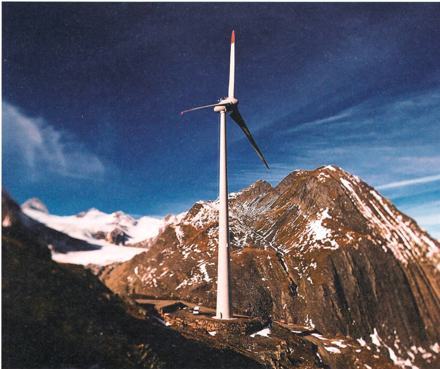
Bild 2 Der Standort am Griespass bietet Vorteile bei der Anbindung ans Strom- und Verkehrsnetz (Nufenenpass), zudem ist die Windturbine vom Tal aus nicht sichtbar.
