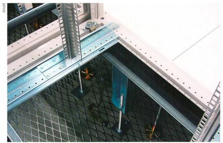
**Bild 4** Die Gitterstruktur bildet die Systembezugsebene für sämtliche darauf platzierten Einrichtungen wie Kabelführungssysteme (Trassen), Bodenrahmen, Verteilschränke, Geräte HLKS-Systeme und Doppelbodenanbindungen. Das Bild zeigt Rackschrankauflage, Doppelbodenstützen und Potenzialvermaschung mittels flexiblem Band.
