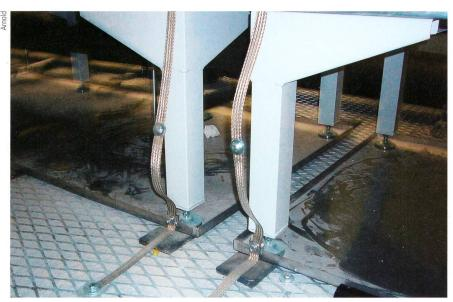
Bild 6 Beispiel von Konstruktionsanschluss (Umluftkühler) mit flexiblem Band an die SRPP.
