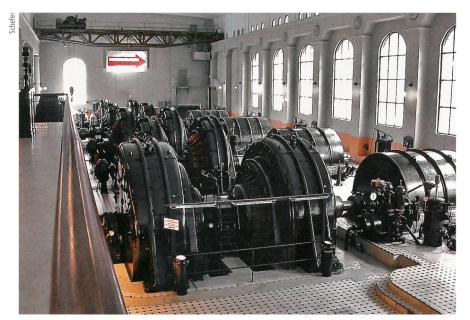
Bild 4 Maschinensaal Ausrüstungsstand ähnlich zur Situation 1929, KW Vemork (2012).
