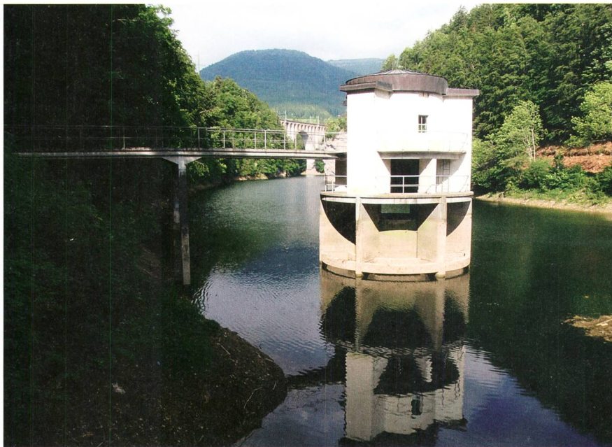
Figure 9 Retenue du Day sur l'Orbe dans le canton de Vaud, site d'un projet de turbinage du débit de dotation (débit: 600 l/s, chute: 28 m, puissance électrique: 130 kW, mise en service en 2014).
