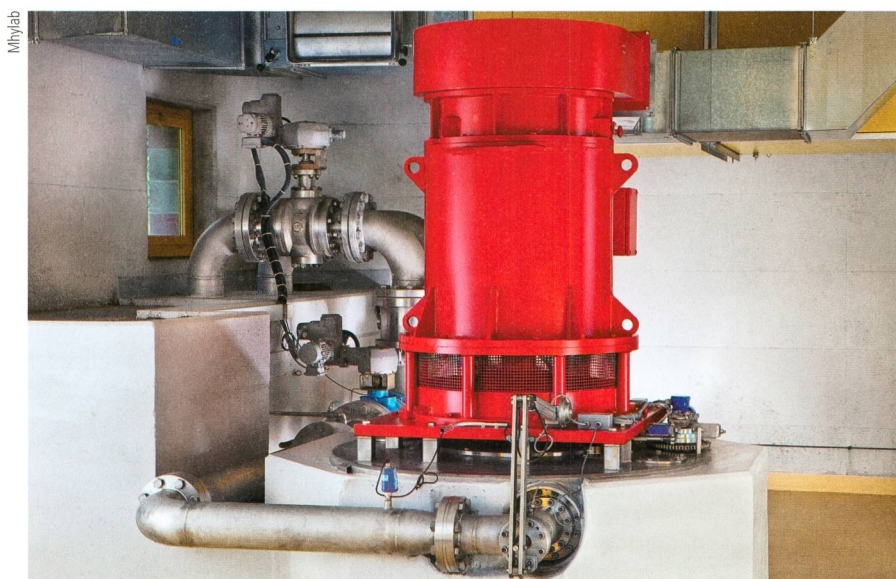
Figure 8 Turbogroupe Pelton sur les eaux usées de Verbier/VS, centrale du Profray (débit : 100 l/s, chute : 430 m, puissance électrique : 350 kW, mise en service en 2008).
