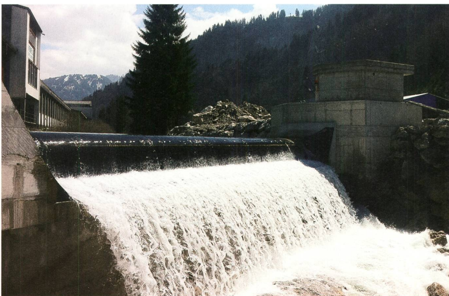
Figure 5 Seuil réhabilité sur la Tzintre, dans le canton de Fribourg, lors de la fusion de deux centrales (débit : 5 m 3 /s, chute : 11 m, puissance électrique : 450 kW, mise en service en 2013).
