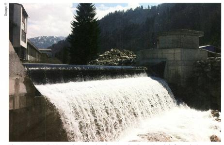
**Figure 5** Seuil réhabilité sur la Tzintre, dans le canton de Fribourg, lors de la fusion de deux centrales (débit: 5 m³/s, chute: 11 m, puissance électrique: 450 kW, mise en service en 2013).
