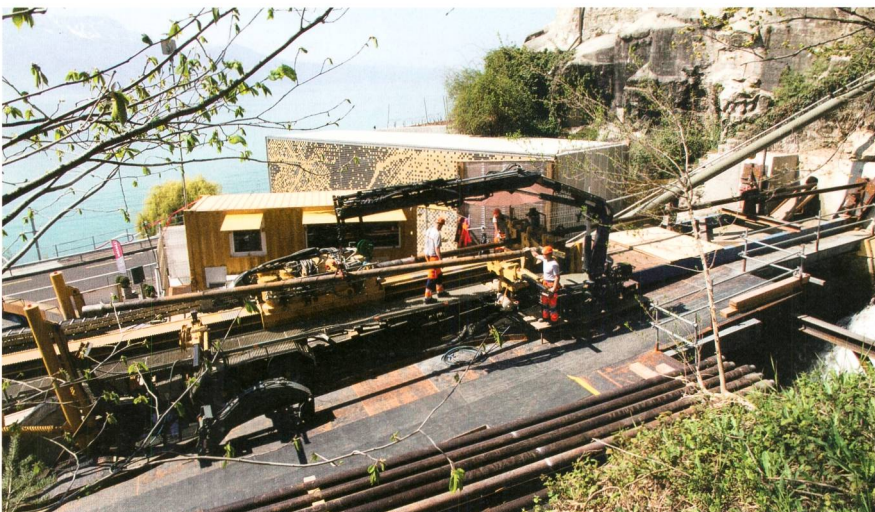
Figure 6 Chantier du forage dirigé de la réhabilitation du site de Rivaz/VD, au bord du lac Léman (débit : 500 l/s, chute : 178 m, puissance électrique : 730 kW, mise en service prévue en 2014).
