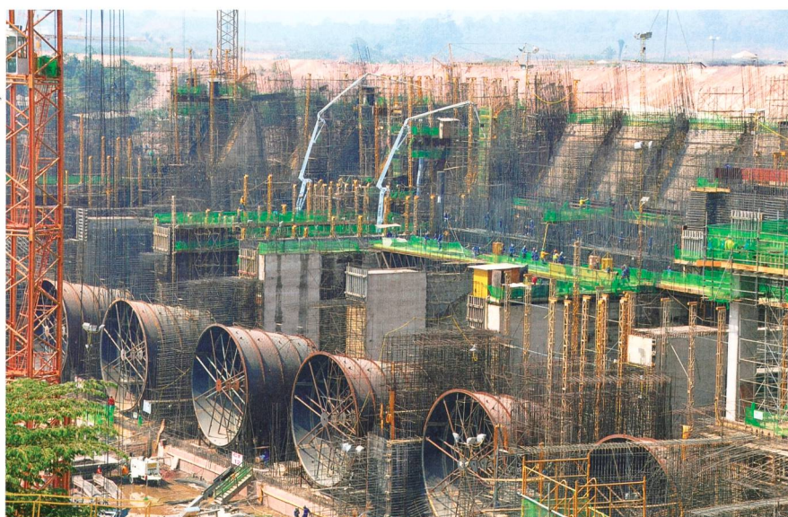
Figure 4 Mise en place de l'armature des aspirateurs de la centrale rive droite en cours de construction, 30 août 2012.
