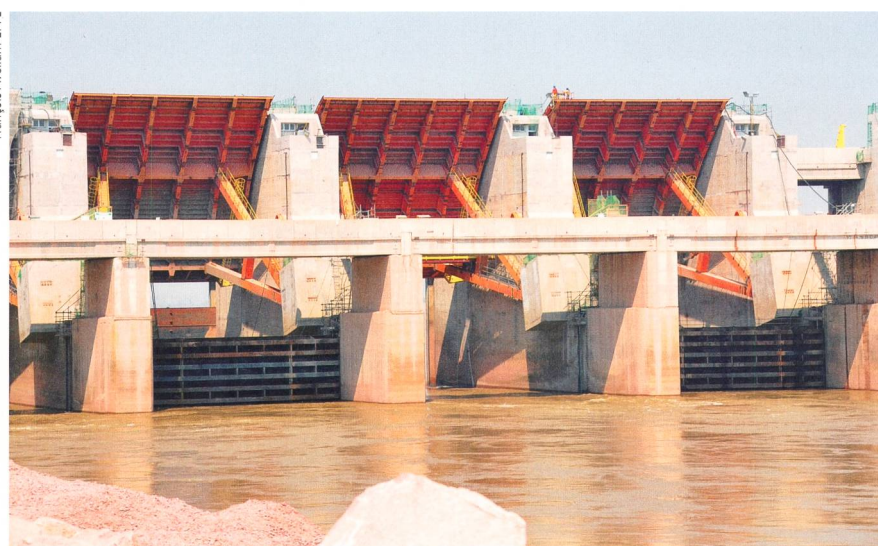
Figure 3 Trois vannes secteurs de l'évacuateur de crue vues de l'aval, largeur 20 m, 30 août 2012.
