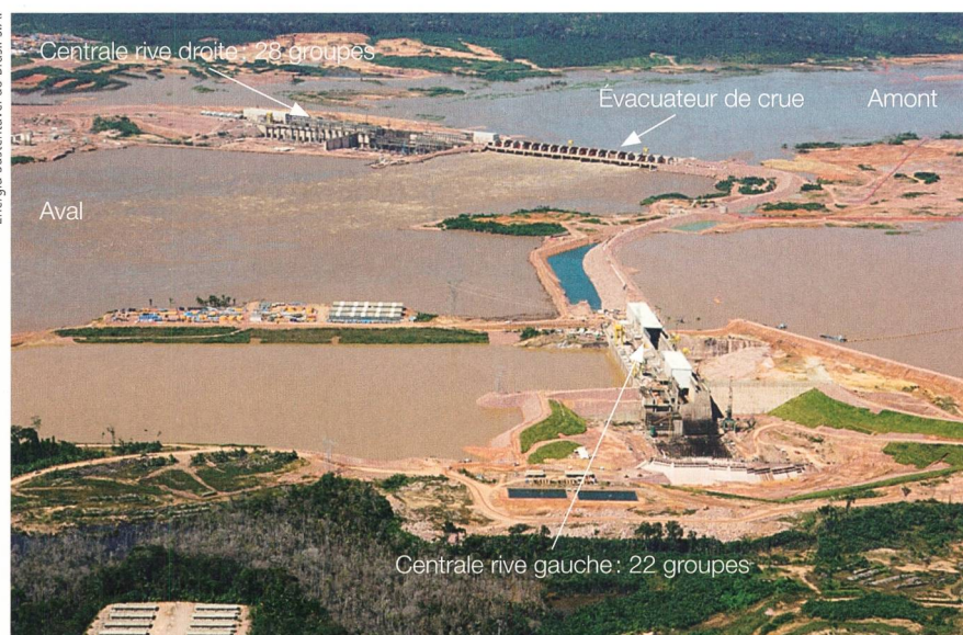
Figure 2 Vue aérienne de l'aménagement de Jirau en cours de construction, 22 avril 2013.
