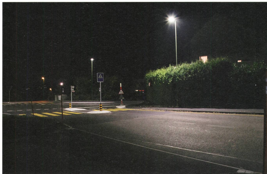
Bild 4 Dank der Richtwirkung ermöglicht die LED-Beleuchtung eine helle Strasse bei dunkler Fassade.
