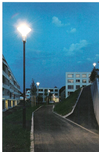
Bild 1 LED-Wegleuchten mit indirekter Beleuchtung. Statt dieser dekorativen Lösung werden in der Regel direkte Optiken eingesetzt.
