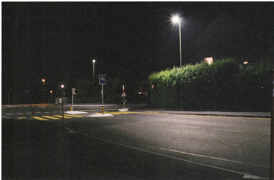
Bild 4 Dank der Richtwirkung ermöglicht die LED-Beleuchtung eine helle Strasse bei dunkler Fassade.
