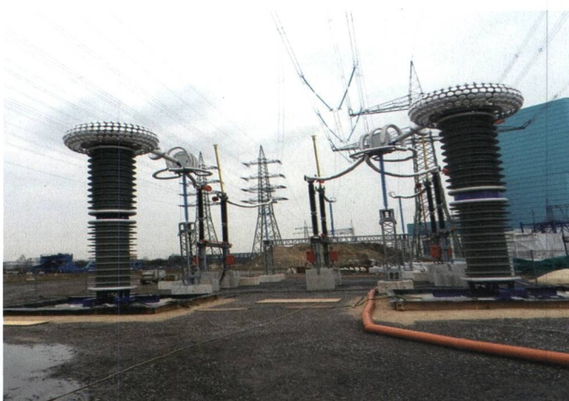
Feldversuche von Amprion in Datteln (Deutschland) bestätigten 2012 die technische Machbarkeit von Hybridleitungen.
