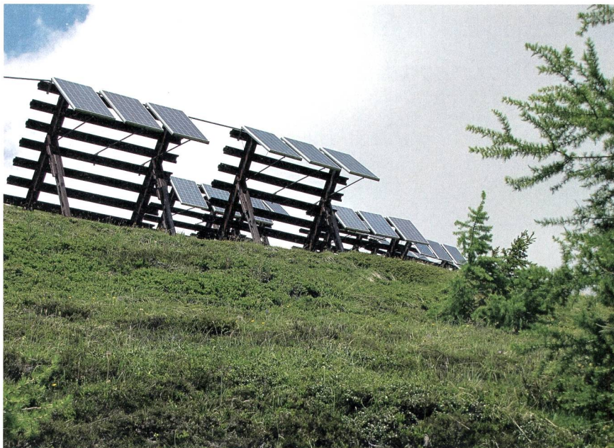
Bild 2 Dank über 300 Sonnentagen jährlich hat die Fotovoltaik im Wallis ein grosses Potenzial. Im Bild: Solarmodule auf einer Lawinenüberbauung im Obergoms.
