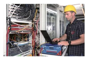
Signalanalyse in einem hybriden System mit Daneo 400.
