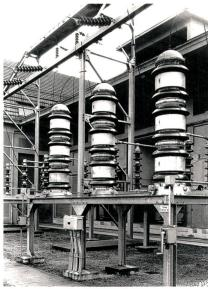
**Bild 1** Einer der ersten kommerziell eingesetzten Spannungswandler für Hochspannung im Jahr 1936 (von Emil Pfiffner).
