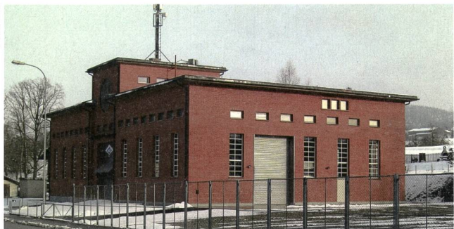
Bild 3 Das Unterwerk Oberuzwil wird als Folge der Analyseergebnisse vollständig aufgelöst.
