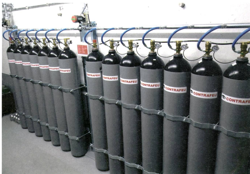
Stickstoffflaschenbatterie für zwei Löschbereiche mit mechanischer Blockiervorrichtung.
