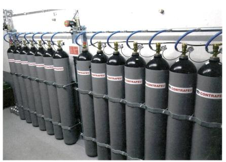
Stickstoffflaschenbatterie für zwei Löschbereiche mit mechanischer Blockiervorrichtung.
