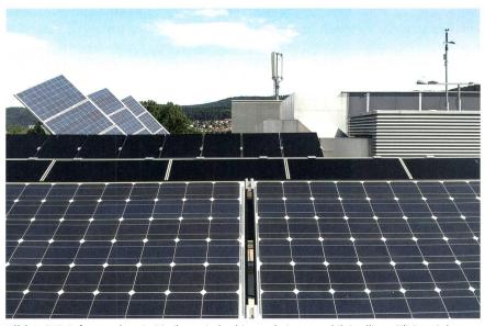
**Bild 1** EKZ-Referenzanlage in Dietikon mit den hier analysierten multikristallinen Silizium-Solarmodulen im Vordergrund.[2]
