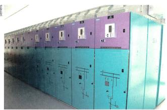
Bild 5 Luftisolierte Siemens-Schaltanlage NXAIR in Duplex-Ausführung, in Betrieb im UW Wil.
