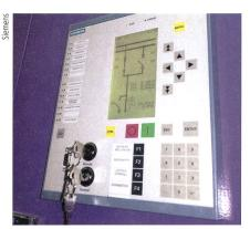
Bild 3 Schutz- und Steuergerät Siprotec 4.
