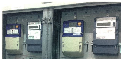
Der AS1440 als Lastgangzähler mit Wandleranschluss – die Einbindung in bestehende Infrastruktur ist problemlos möglich.
