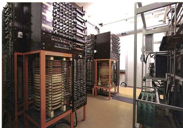
Bild 3 Induktivitäten zur Wirkfaktorsteuerung des Prüfstroms.
