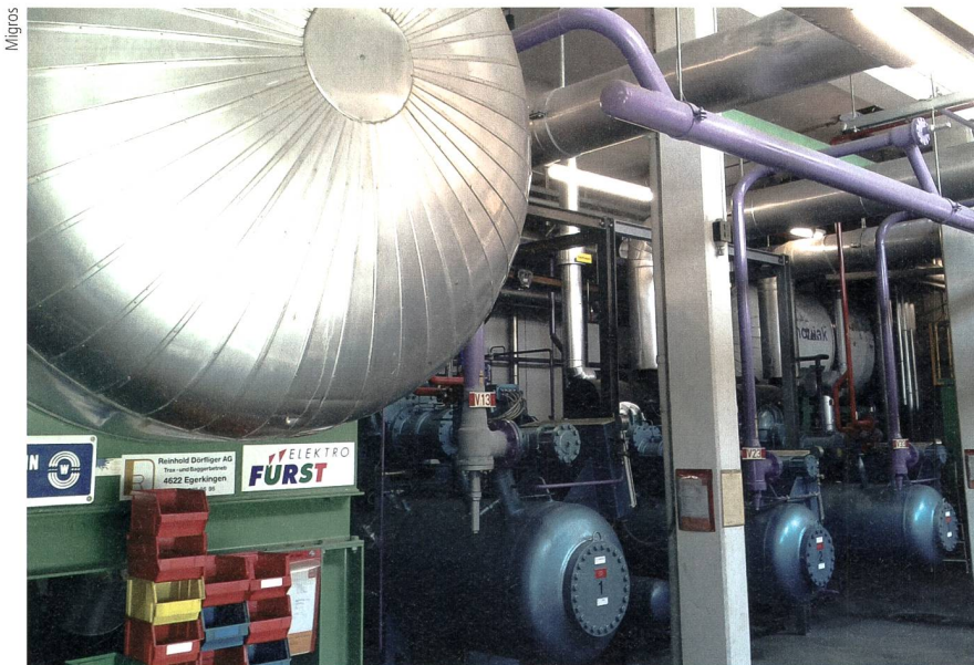
Bild 2 Kühlanlage eines Tiefkühlagers.
