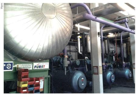
Bild 2 Kühlanlage eines Tiefkühllagers.
