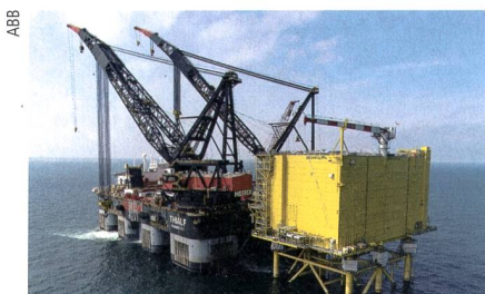
320-kV-Umrichterstation mit 800 MW Leistung.
