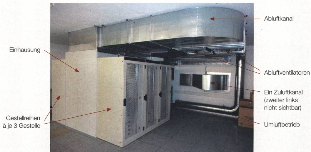
Bild 3 Anordnung des Pilot-RZ. Eine Trennwand wurde zur Abgrenzung des Pilotraumes später noch eingebaut.
