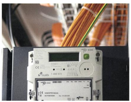
Bild 2 Schlüsselelement Kommunikation: ein GSM/GPRS-Kommunikationsmodul.
