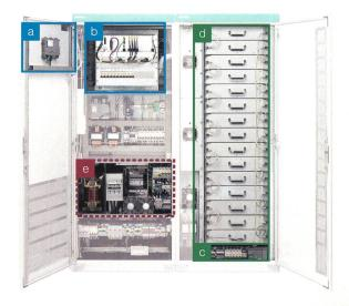
**Bild 5** Aufbau eines Batterieracks.
