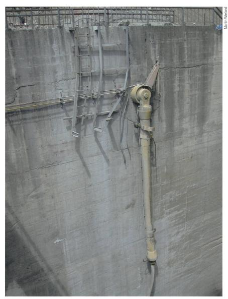
**Bild 3** Durch Steinschlag zerstörte und weggeschwemmte Schütze eines Flusskraftwerks; nur der Hydraulikzylinder ist übrig geblieben (Wenchuan-Erdbeben 2008, Sichuan, China).
