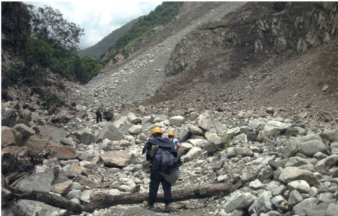
Bild 8 Zugeschüttete Verbindungsstrasse zur Shapai-Bogenmauer (Wenchuan-Erdbeben 2008, Sichuan, China).
