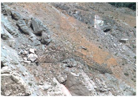
Bild 7 Zerstörte Hochspannungsleitung der Sefid-Rud-Stauanlage (Manjil-Erdbeben 1990, Iran).
