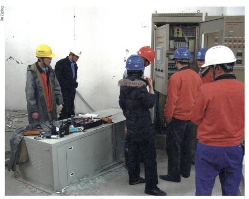
**Bild 1** Umgestürzter Schaltschrank zur Bedienung der Hochwasserentlastung des Zipingpu-Damms (Wenchuan-Erdbeben 2008, Sichuan, China).
