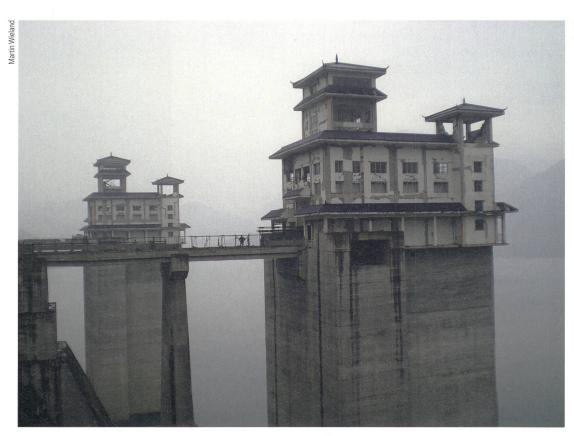
**Bild 2** Einlaufbauwerke für die Zipingpu-Stauanlage mit beschädigten Bedienungsgebäuden (Wenchuan-Erdbeben 2008, Sichuan, China).
