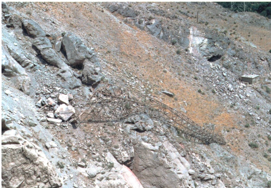
Bild 7 Zerstörte Hochspannungsleitung der Sefid-Rud-Stauanlage (Manjil-Erdbeben 1990, Iran).
