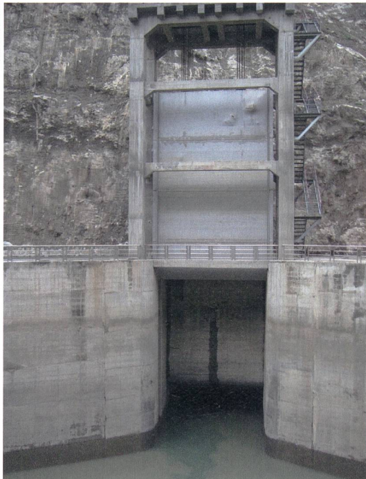
Bild 4 Durch Steinschlag beschädigte Tafelschütze eines Flusskraftwerks (Wenchuan-Erdbeben 2008, Sichuan, China).
