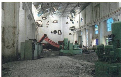
Bild 6 Überschwemmtes Maschinenhaus der Shapai-Stauanlage und Beschädigung der Stirnwand und Dachkonstruktion sowie des Krans durch Steinschlag (Wenchuan-Erdbeben 2008, Sichuan, China).
