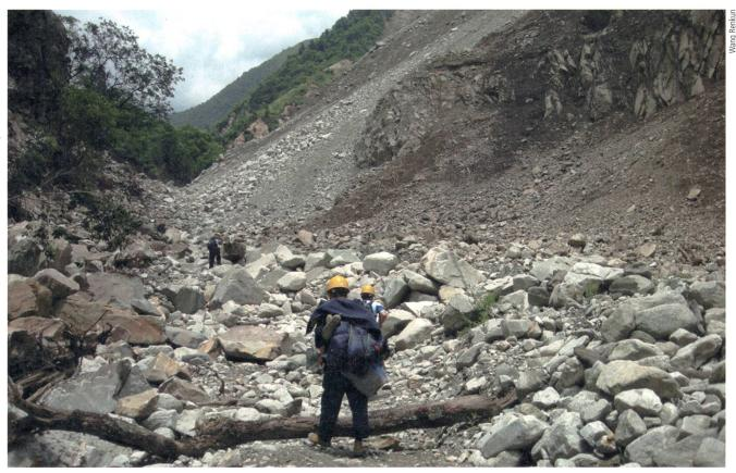
Bild 8 Zugeschüttete Verbindungsstrasse zur Shapai-Bogenmauer (Wenchuan-Erdbeben 2008, Sichuan, China).
