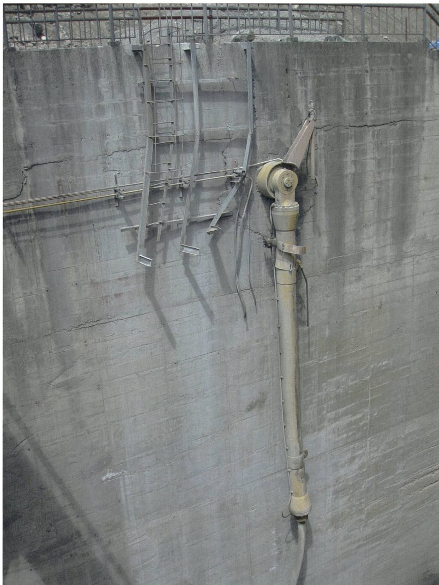
Bild 3 Durch Steinschlag zerstörte und weggeschwemmte Schütze eines Flusskraftwerks; nur der Hydraulikzylinder ist übrig geblieben (Wenchuan-Erdbeben 2008, Sichuan, China).
