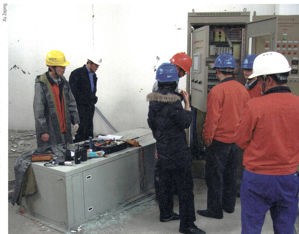
Bild 1 Umgestürzter Schaltschrank zur Bedienung der Hochwasserentlastung des Zipingpu-Damms (Wenchuan-Erdbeben 2008, Sichuan, China).
