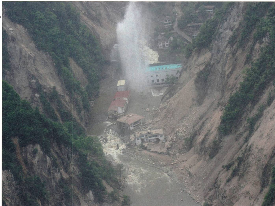
Bild 5 Versagen der Druckleitung der Shapai-Stauanlage verursacht Fontäne und Überschwemmung des Maschinenhauses, der umliegenden Gebäude und der Schaltanlage (Wenchuan-Erdbeben 2008, Sichuan, China).
