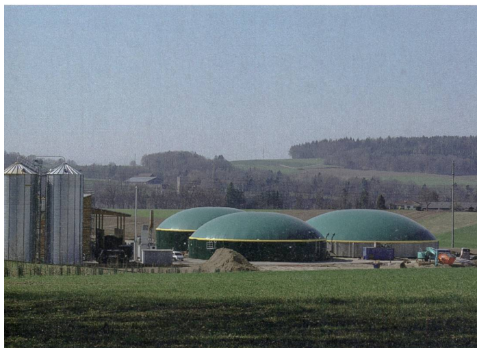
La centrale à biomasse de l'Energiepark de Guin (Düdingen) produit 2,2 GWh d'électricité par an. Sa construction a duré douze mois.
