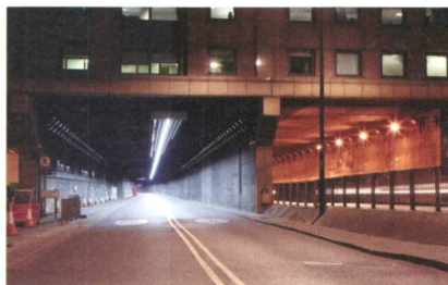
Weisses LED-Licht erhöht die Sicherheit in Tunnels.
