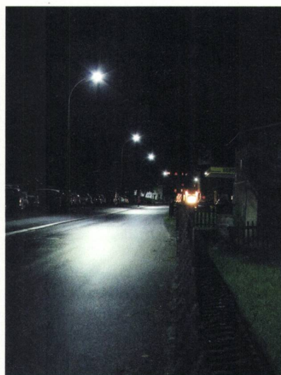
Figure 3 En 2015, les lampes à vapeur de mercure et certaines lampes à vapeur de sodium haute pression disparaîtront de l'éclairage public. Elles commencent à être remplacées par des LED froides (image de gauche) (smart lighting). Une alternative consisterait à utiliser des lampes à vapeur de sodium performantes (image de droite).
