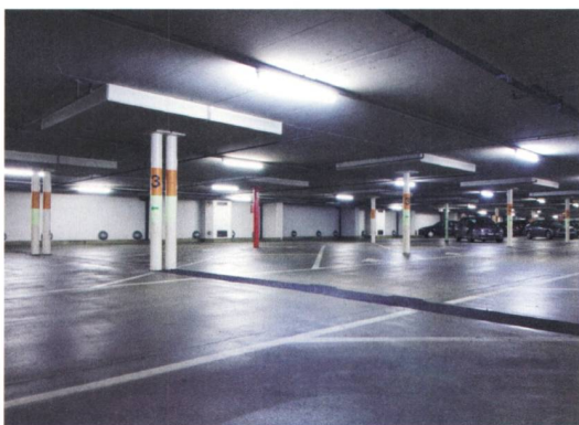
Bild 3 Parkhaus vor der umfassenden Sanierung.
