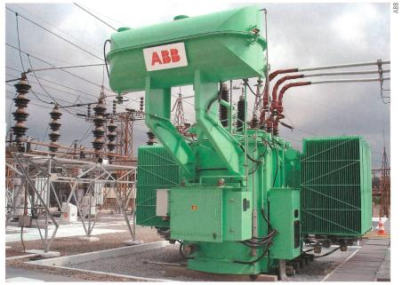
Figure 3 Transformateur ABB de 25 MVA, 138 kV, rempli avec l'huile ester naturel Biotemp.
