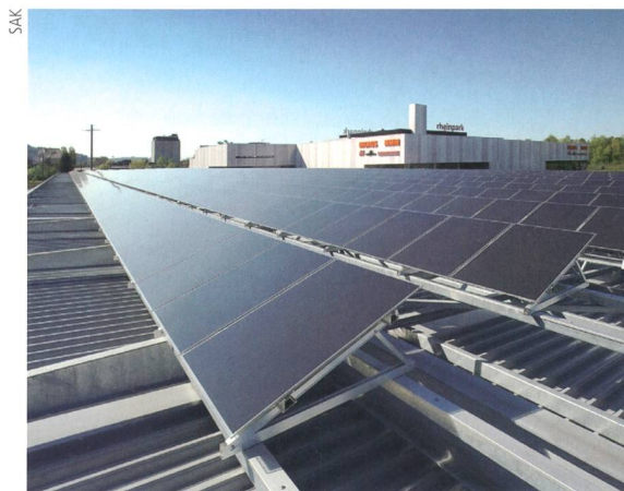
Fotovoltaik im sanktgallischen St. Margrethen: Solche Anlagen können eine Verstärkung des Netzes erfordern.
