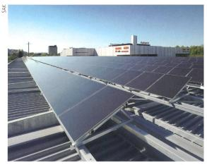
Fotovoltaik im sanktgallischen St. Margrethen: Solche Anlagen können eine Verstärkung des Netzes erfordern.
