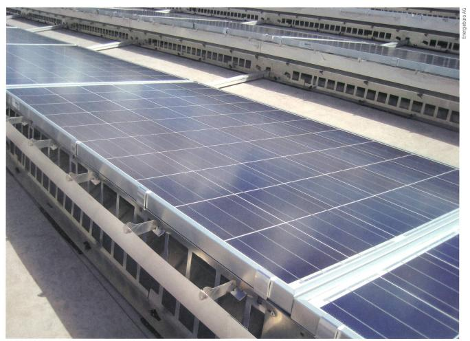
Bild 3 Leichtbauunterkonstruktion mit Spoiler am Heck des Aufständerungssystems.
