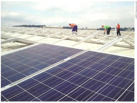
Bild 7 Modulmontage der 25 000 m² grossen Anlage auf der Industriehalle der Ferrowohlen AG.
