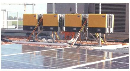
**Bild 6** Die neueste Generation der Wechselrichter erreicht mit rund 98 % den höchsten Wirkungsgrad. Das Bild stammt aus der Bauphase der Solaranlage Pistor-Edisun Power.
