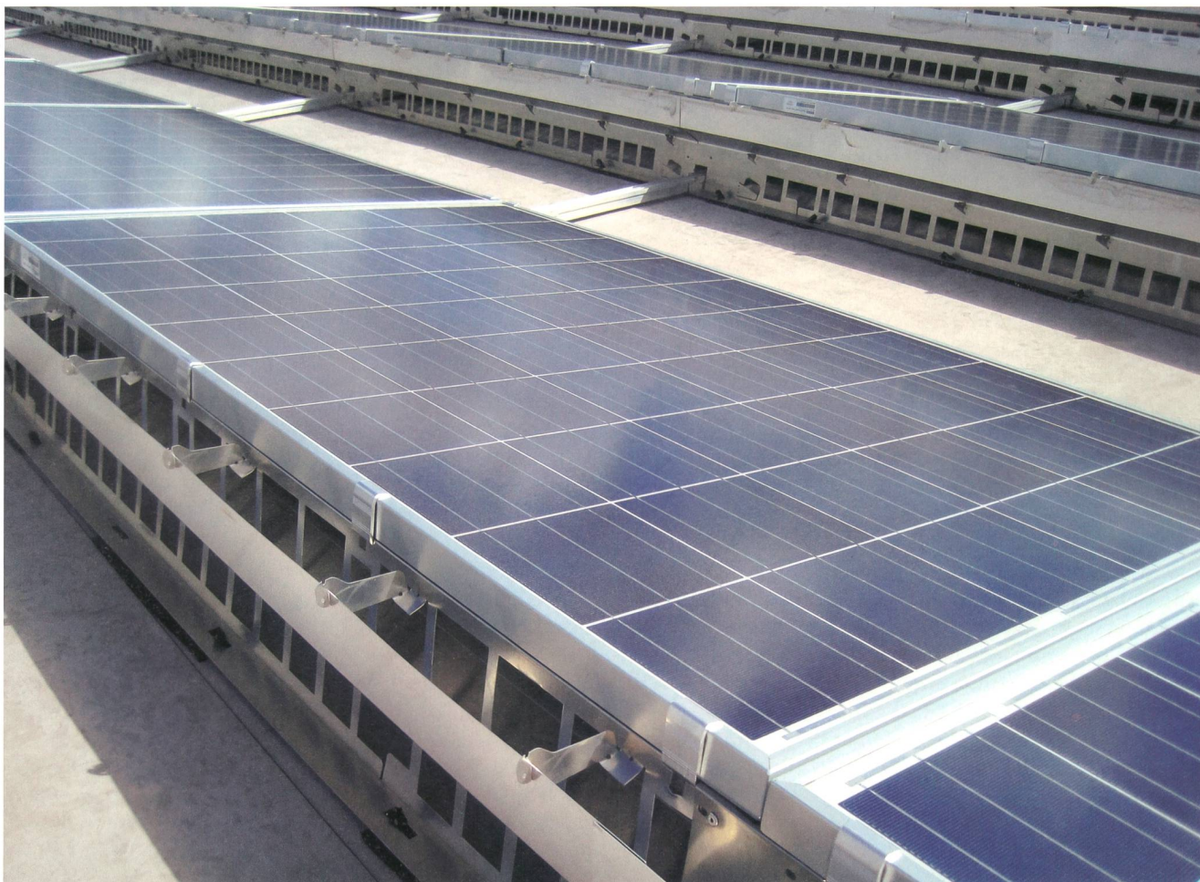
Bild 3 Leichtbauunterkonstruktion mit Spoiler am Heck des Aufständersystems.
